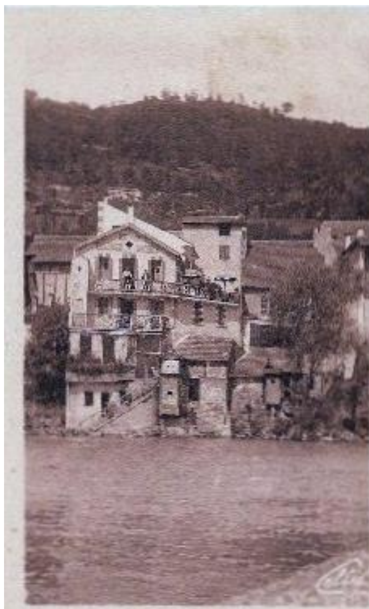
Vue côté Ariège.
